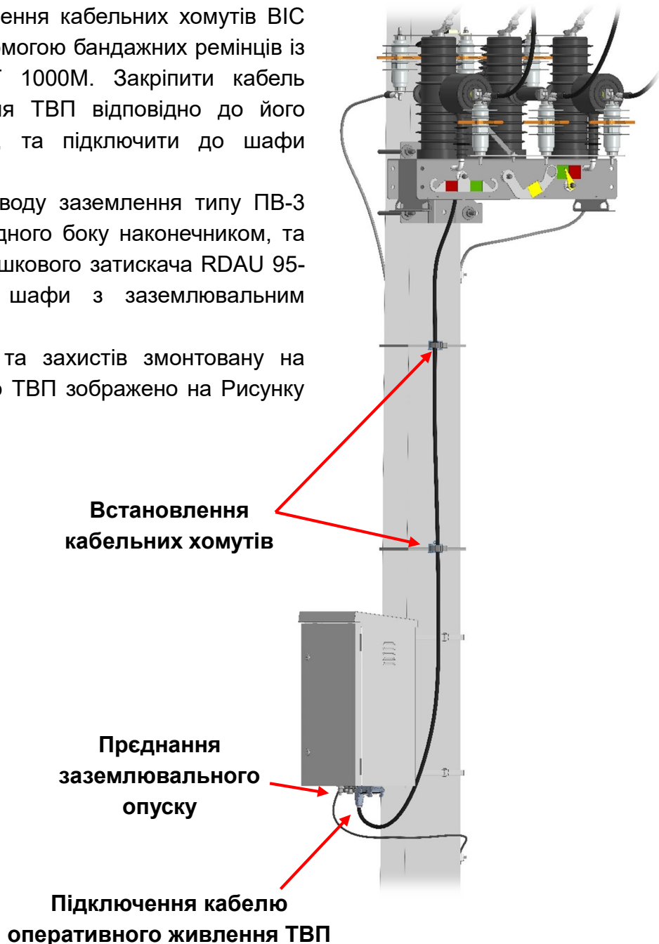
Рис. 7.8.1 Монтаж та підключення шафи управління та захистів
